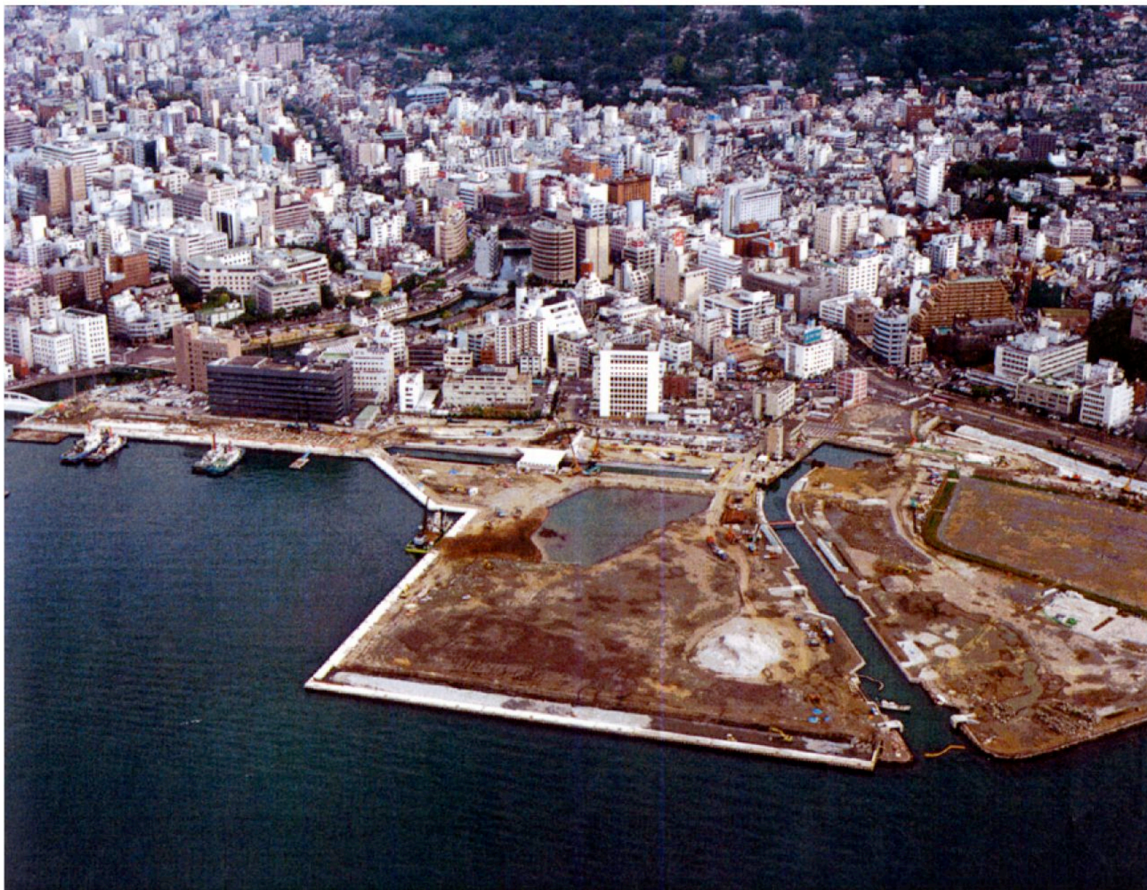
施工中 写真 - b
