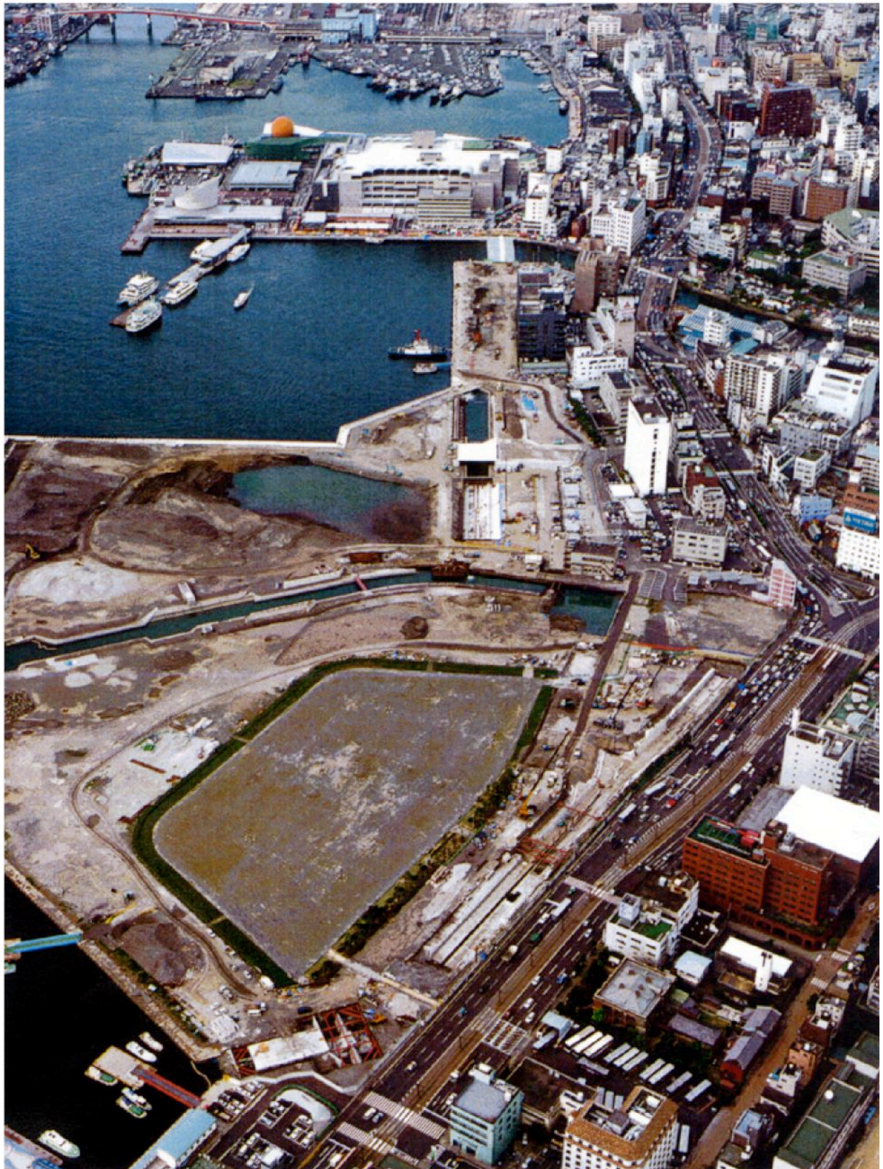
施工中 写真 - a
